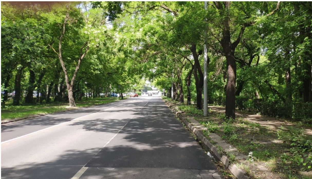
XI. kerület Rákóczi híd lehajtó egyrétegű aszfaltjavítás 2126 négyzetméteren
