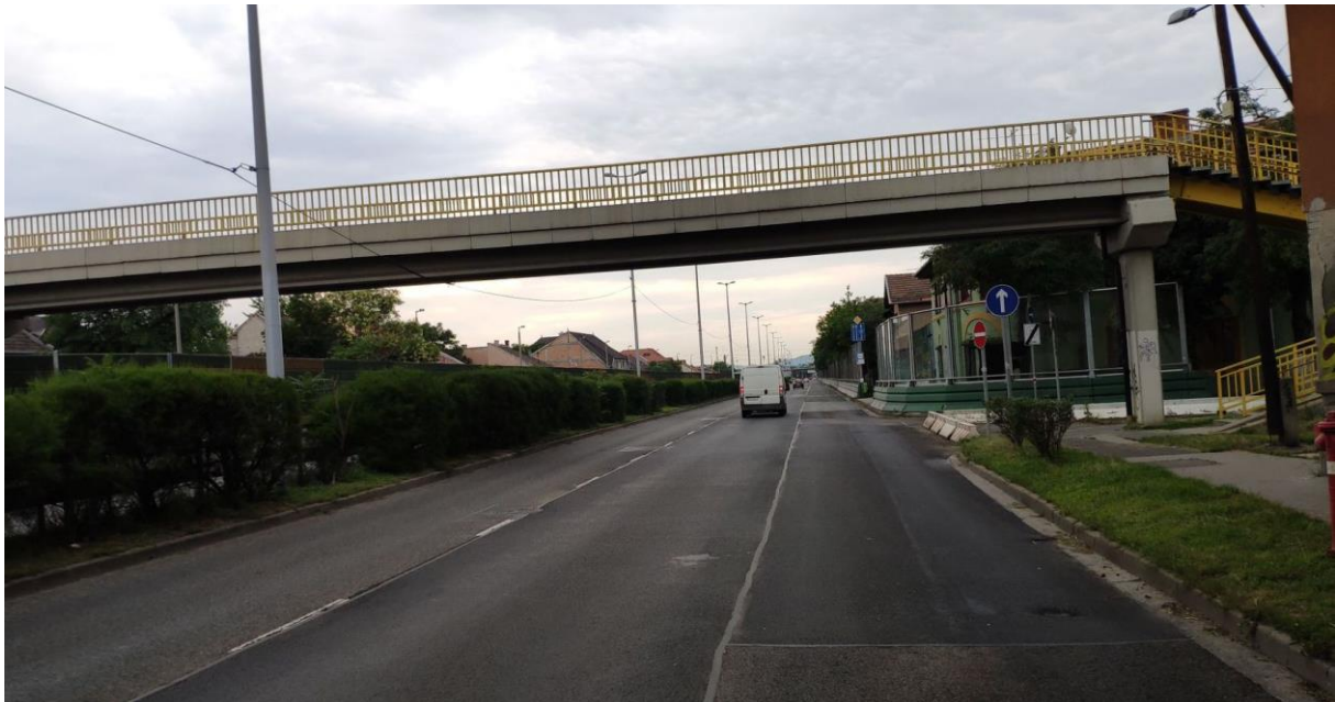
XIX. kerület M5 bevezető – Nagykőrösi út – egyrétegű aszfaltjavítás 174,3 négyzetméteren
