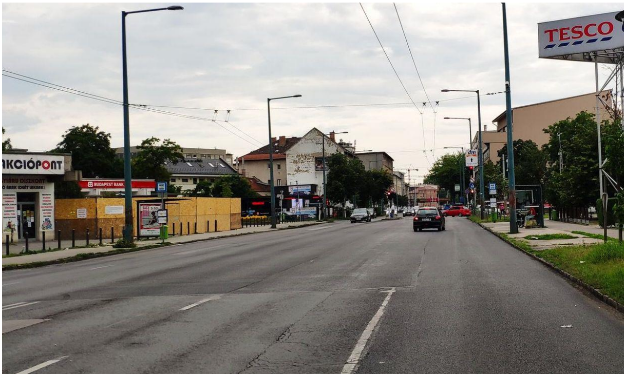
XIV. kerület Fogarasi út TESCO – kétrétegű aszfaltjavítás 108,8 négyzetméteren
