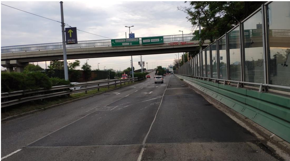
XIX. kerület M5 bevezető – Nagykőrösi út – kétrétegű aszfaltjavítás 1096,99 négyzetméteren
