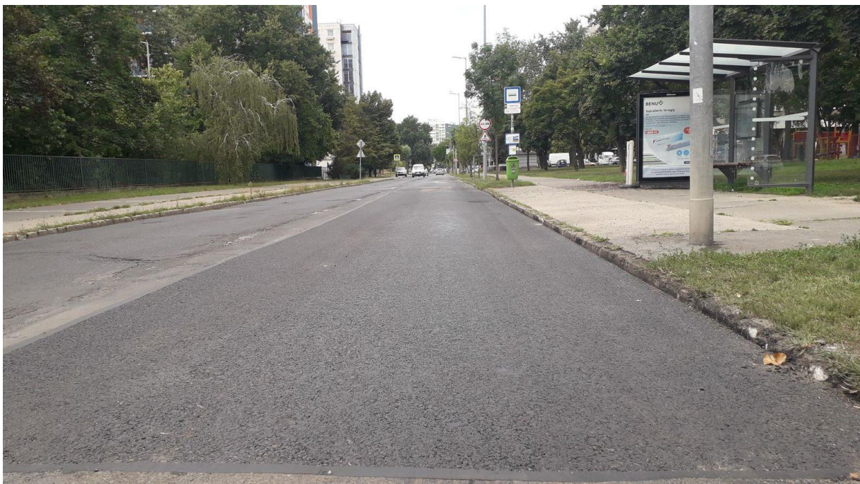
III. kerület Pünkösdfürdő - Boglár utca buszmegálló – kétrétegű aszfaltjavítás 66,3 négyzetméteren
