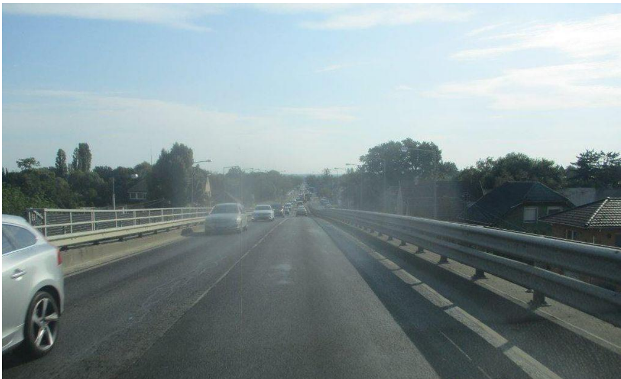
XIV. kerület Fogarasi úti felüljáró lehajtó – egyrétegű aszfaltjavítás 284,4 négyzetméteren
