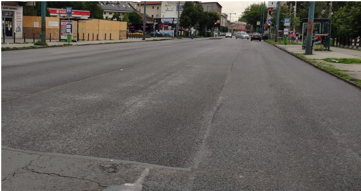
XIV. kerület Fogarasi út TESCO – egyrétegű aszfaltjavítás 714,2 négyzetméteren
